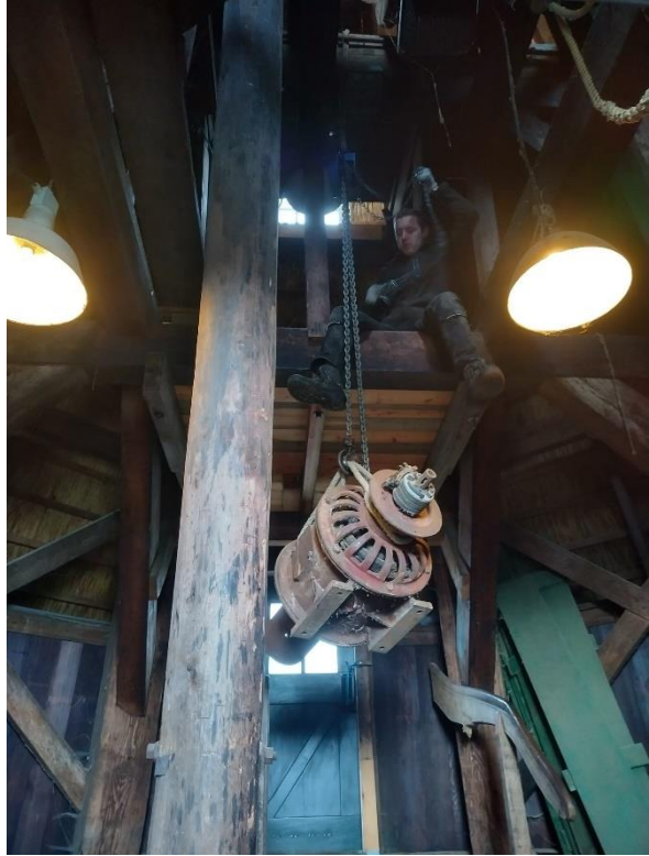
D.m.v. een kettingtakel (westontakel) is de motor op zijn plek gebracht. Op de foto bedient Marc de takel vanaf het zoldertje waar de motor komt te staan.
